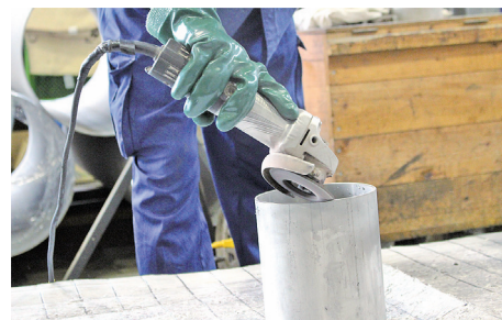
切断端面のバリ取り（細径は専用機を使用）
